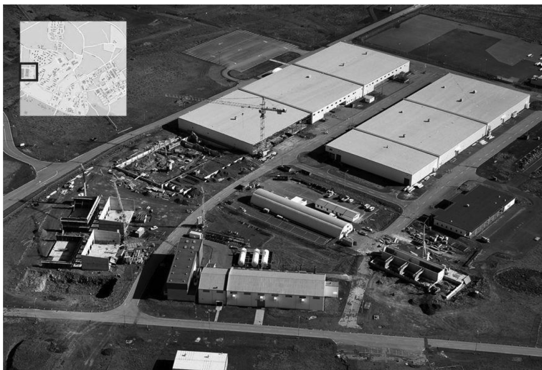
Bild 2. Anläggningen(2009). Byggnaderna 869 och 868 är de stora byggnaderna, 872 är den mindre byggnaden till höger (brunt tak), 866 är byggnaden i mitten (blått tak) och 864 är byggnaden längst ner (rött tak). De andra (nya) byggnaderna på bilden uppfördes av Verne under åren 2008-2009.
