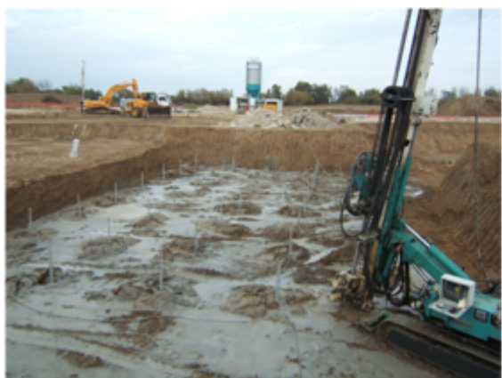
Schaktning och pålning
