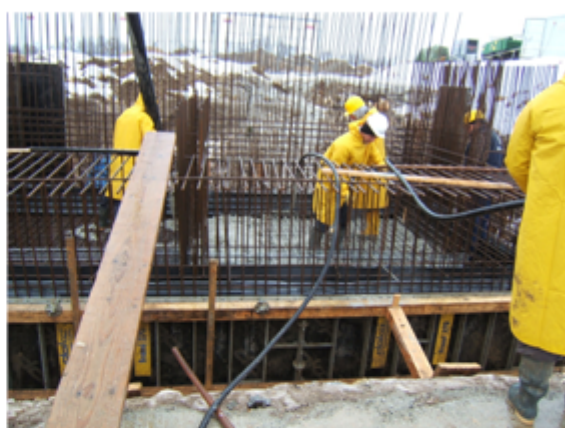
Grunden gjuts i betong
