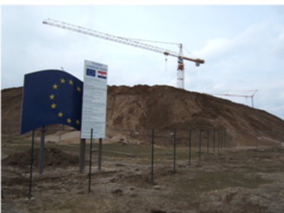
Entrén till byggarbetsplatsen
