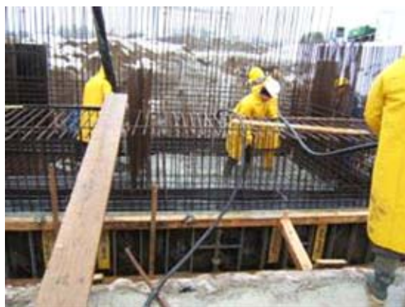
Vylievanie základov betónom
