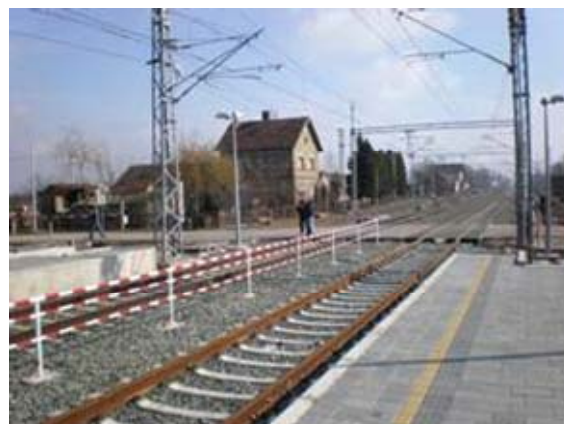
Stanica Ďeletovci – pohľad na východ
