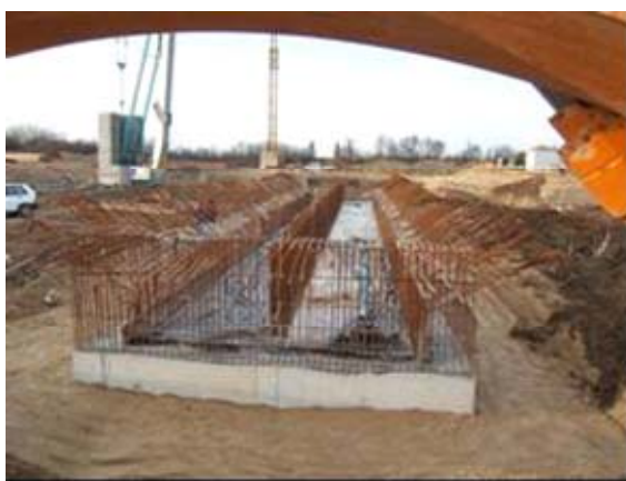
Výstavba základov foundations
