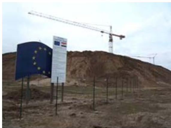
Vstup na stavenisko
