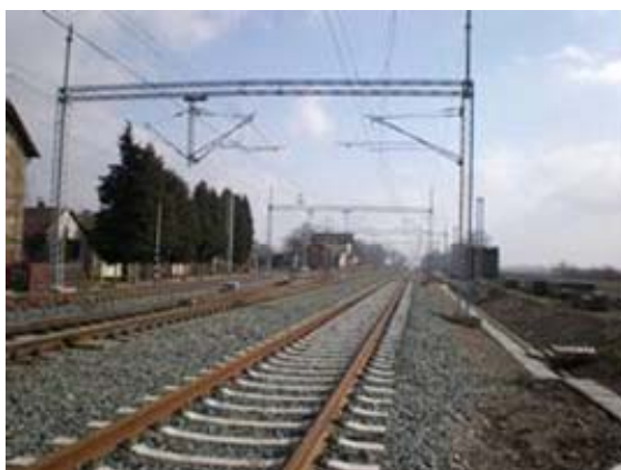
Časť zrekonštruovanej trate
