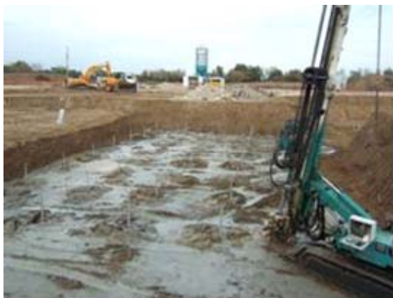
Výkopové a pilotážne práce
