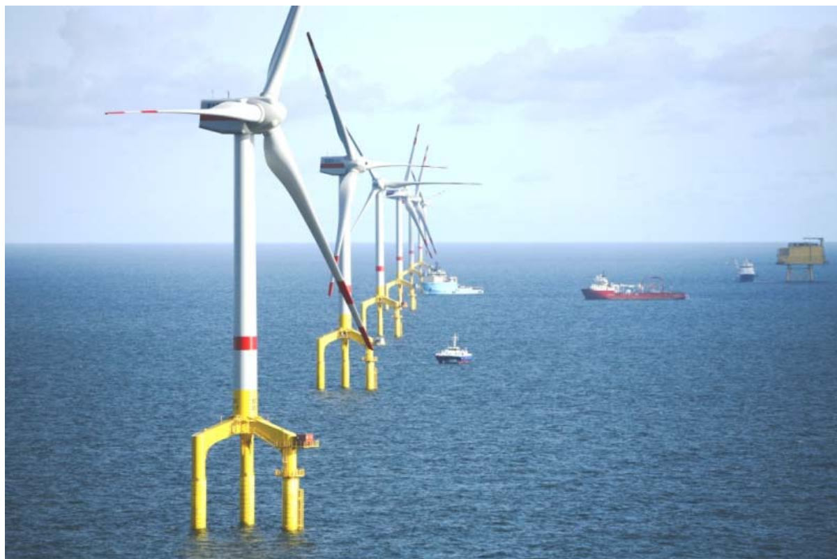
Turbine multi-MW și structuri de fundații offshore, cofinanțate de PEER, instalate pe platforma Bard I în partea germană a Mării Nordului
