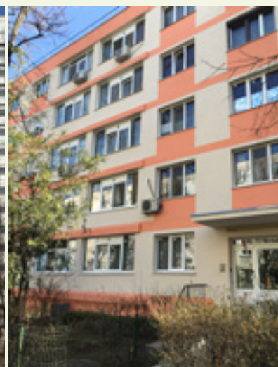
Flatgebouw na de investering (projectlocatie)
