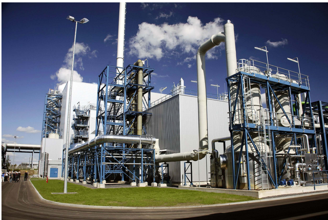
CCS izmēģinājuma iekārta Jenšvaldē, Vācijā
