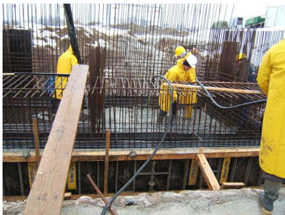
Betona pamatu liešana
