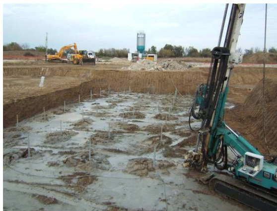
Rakšanas un pāļu dzīšanas darbi
