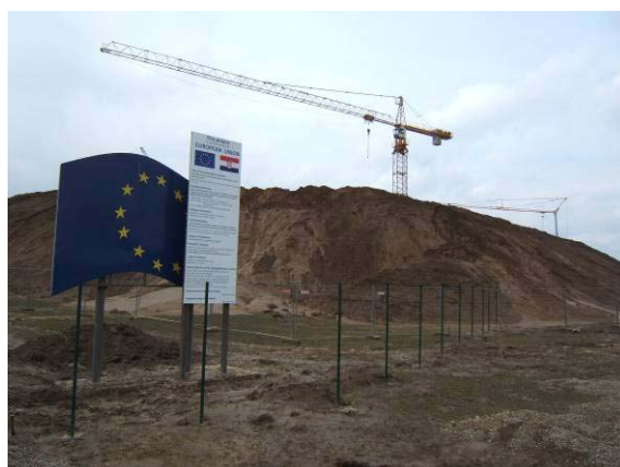
Ingresso del cantiere
