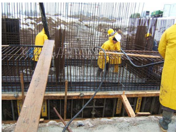
Gettata delle fondamenta in calcestruzzo
