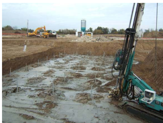
Scavi e palificazione
