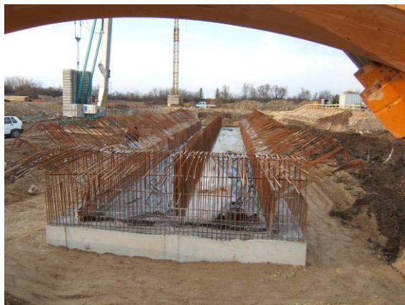
Costruzione delle fondamenta
