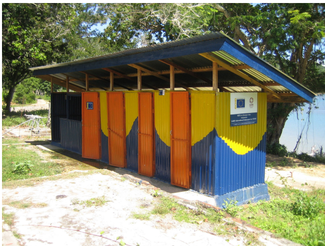
Szennyvízelvezetés: melléképítmények Acehben, Indonéziában (Forrás: Európai Számvevőszék)
