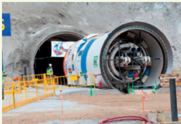
Fotografija 2. – Dio istosmjernog visokonaponskog spojnog voda u trenutku ugradnje u tunel kroz Pireneje
