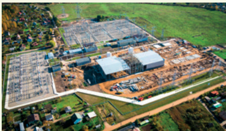
Fotografija 3. – Kopnena trafostanica iz projekta NordBalt u Klaipėdė, Litva
