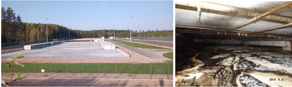
Figure 8: nouvelle décharge pour déchets de faible activité et chambre de stockage de déchets bitumés
