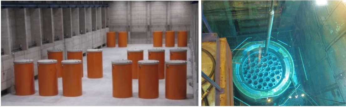
Figure 7: installation d'entreposage provisoire et nouveaux châteaux pour les assemblages combustibles usés
