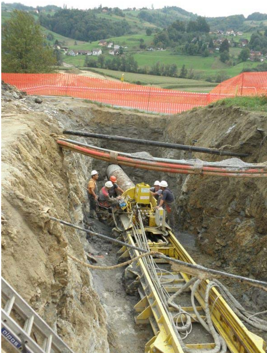
Kaasunsiirtojärjestelmän kunnostusta Sloveniassa Itävallan rajan ja Ljubljanan välillä
