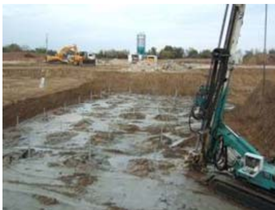
Maansiirto- ja paalutustyöt
