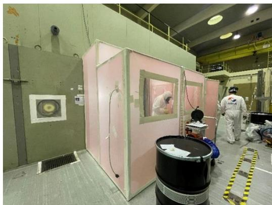
Ispra: descontaminación de celdas calientes en el LCSR
