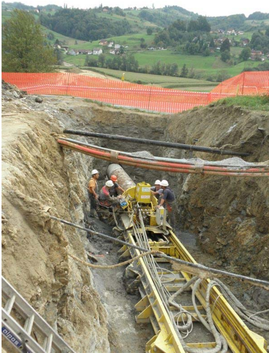
Αναβάθμιση του συστήματος μεταφοράς φυσικού αερίου στη Σλοβενία μεταξύ των συνόρων Σλοβενίας-Αυστρίας και της Λιουμπλιάνας
