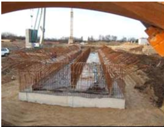
Bau von Fundamenten
