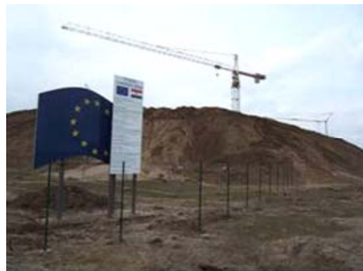
Zugang zur Baustelle
