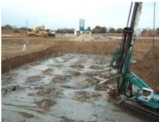
Aushub- und Pfahlarbeiten
