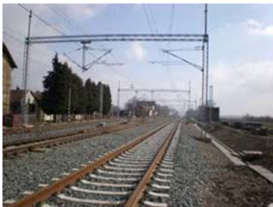
Teil der instandgesetzten Bahnstrecke
