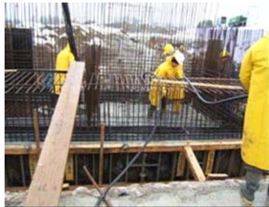
Erstellung von Betonfundamenten
