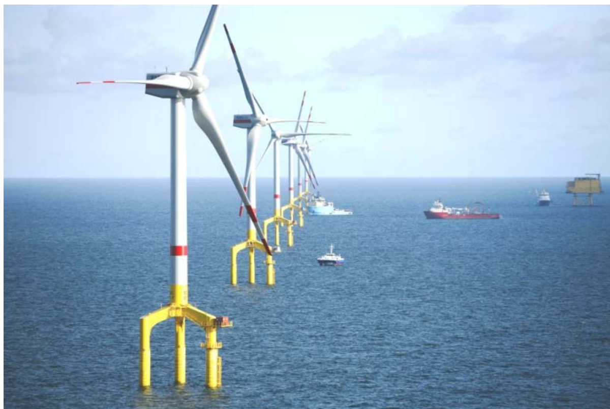
Turbíny s výkonem několika MW a základové konstrukce na moři spolufinancované z EEPR, které jsou instalovány v lokalitě Bard I v německém Severním moři
