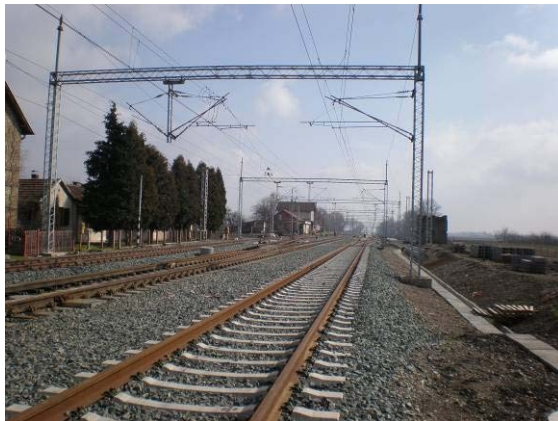
Sezione di ferrovia ricostruita
