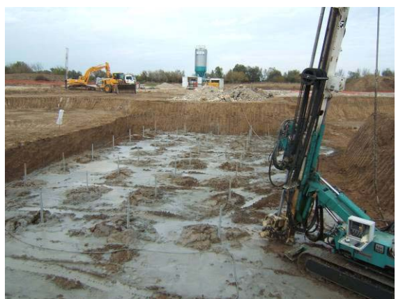
Scavi e palificazione
