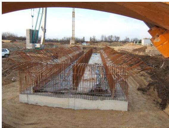
Costruzione delle fondamenta
