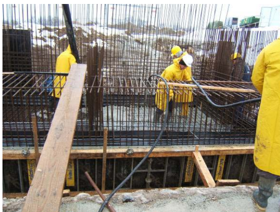
Gettata delle fondamenta in calcestruzzo
