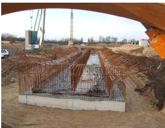
Изграждане на фундаментите фундаментите
