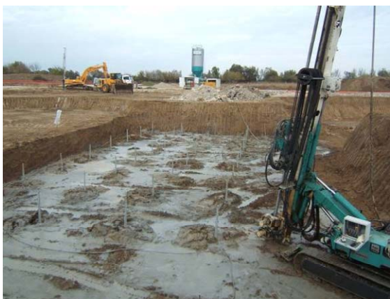
Изкопни работи и набиване на пилотите
