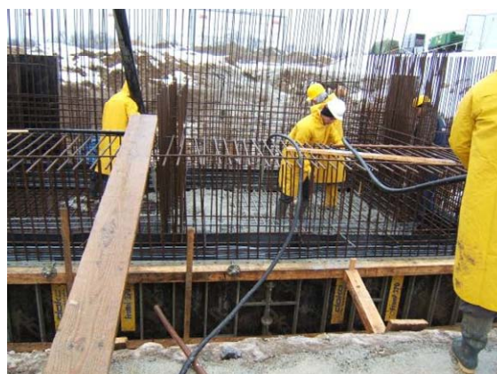
Наливане на бетон върху
