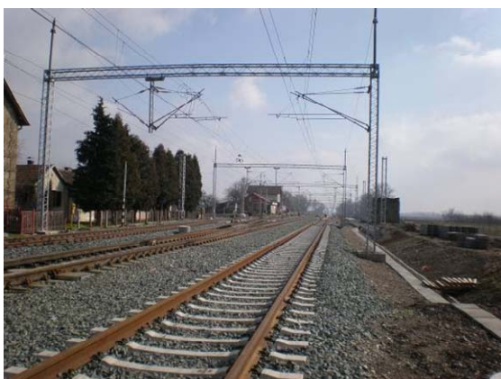
Реконструиран ж.п. участък
