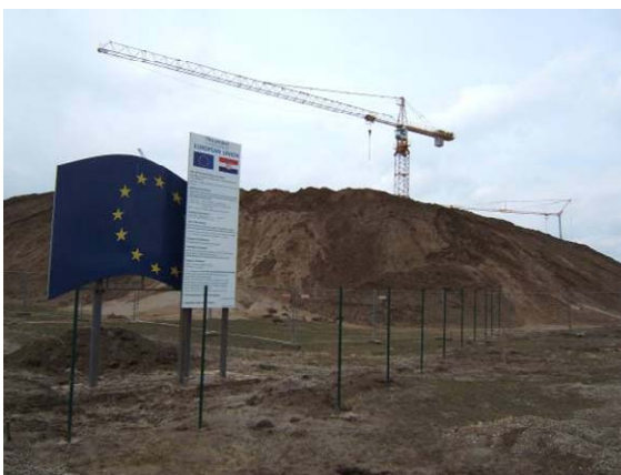
Вход на строителния обект
